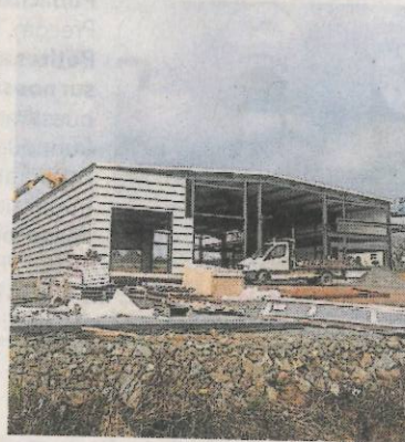
Le garage AS automobile est en construction près de l'espace Paul Peletiers de Saint-Pardoux.
